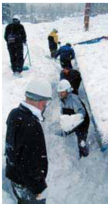
プール更衣室の屋根まで覆われていた雪を除雪していった
